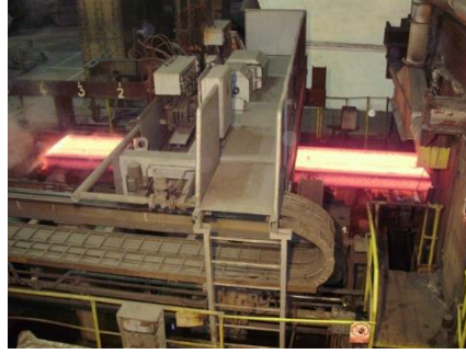
Obrázek č. 5: Měřící místo u bramového kontilití
