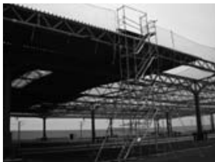
Obr. 13: Volně stojící schodišťová věž
