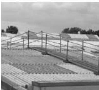
Obr. 15: Povrch, umožňující rozložení zatížení
